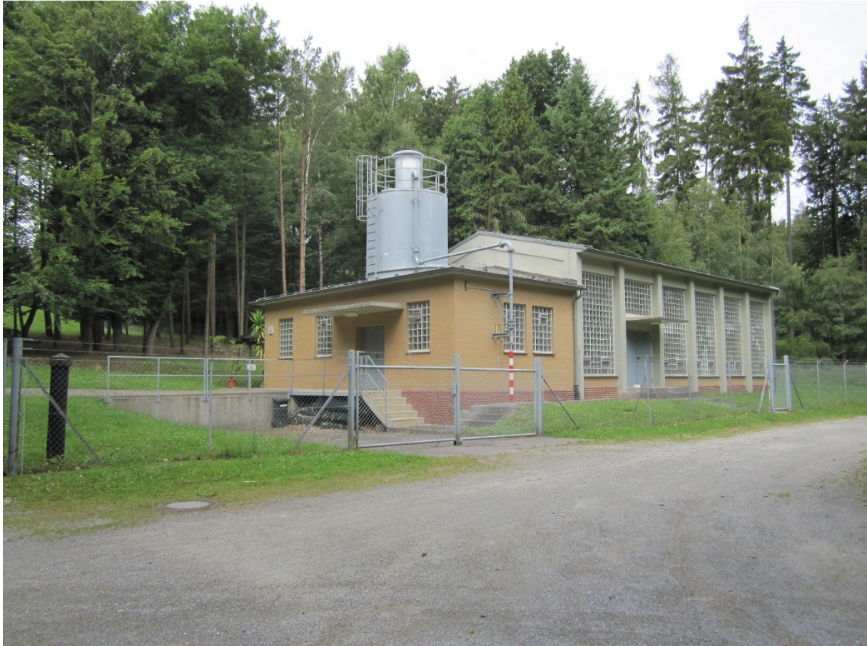
Abb. 4: Trinkwasseraufbereitungsanlage ESA Hohemark
